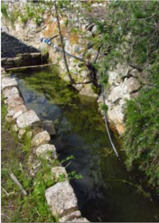
Figura 8 – Esempio di realizzazione di nuova vasca in pietra, alla base di un terrazzo coltivato, con caratteristiche di elevata idoneità per la colonizzazione da parte del discoglossa
